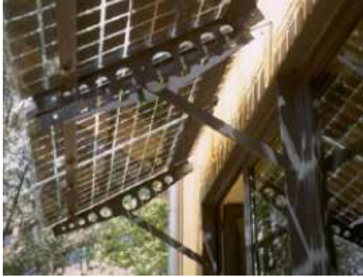
Εικόνα 6.1.2: Στερέωση πλαισίων ανοίγοντας τρύπες σε ζώνες δίχως στοιχεία.
