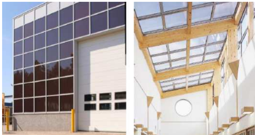
Εικόνα 6.3.1: Παραδείγματα της ένταξης των πλαισίων στην πρόσοψη και θόλο
